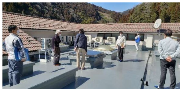
【特養ひろた大規模改修工事完了検査】
